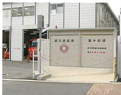
(仮)豊洲出張所内の防災資機材格納庫
